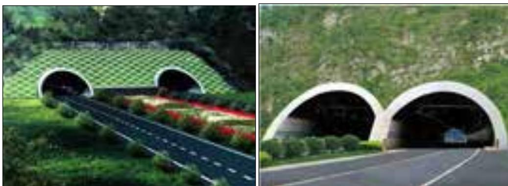
图 2.2-5 主线隧道洞口型式和景观设计效果图
